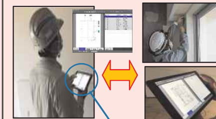
通信端末で内装仕上げの確認・是正
