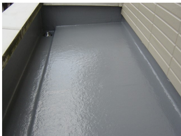
写真 1.2.1 FRP系塗膜防水の 施工の事例
